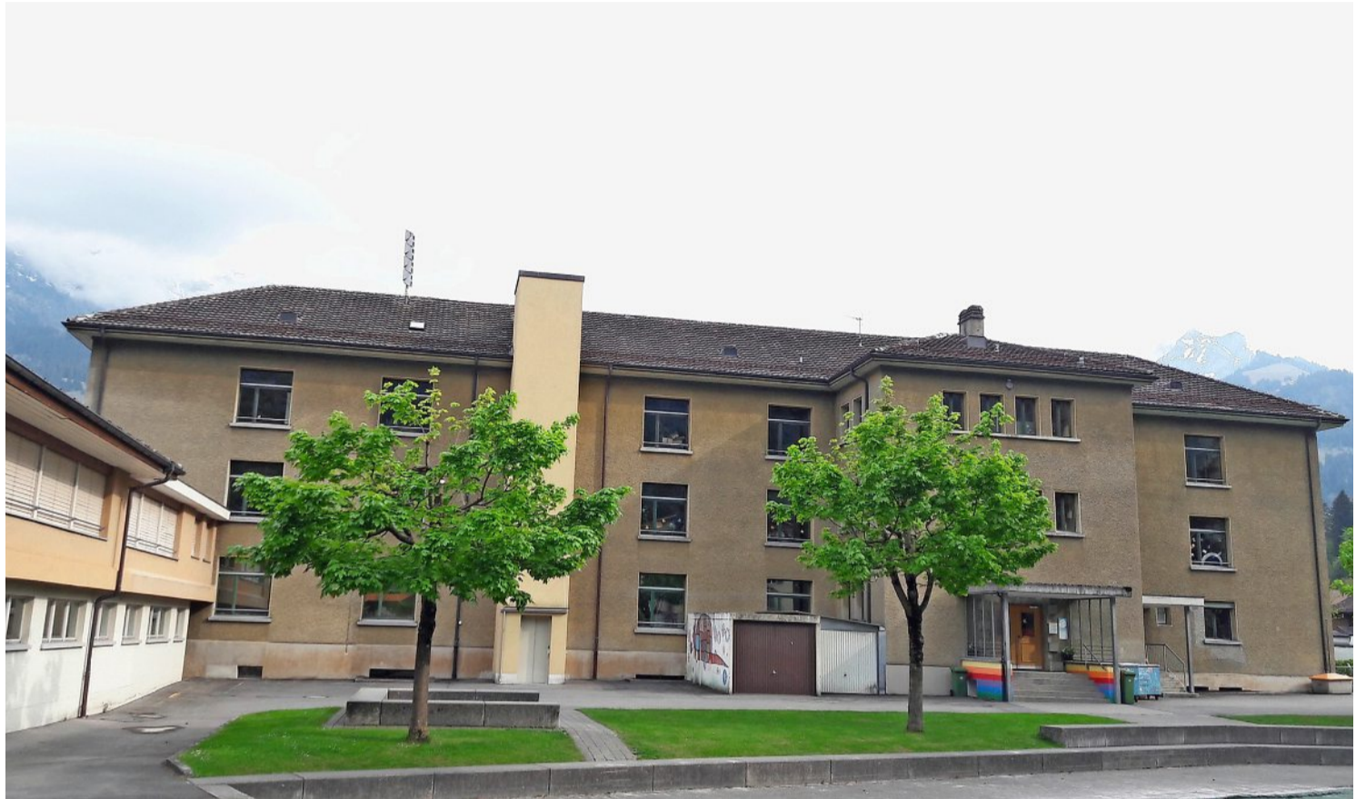
Der «Rucksack» wird an die Nordwestfassade des alten Widi-Schulhauses angebaut. Foto: jsf
