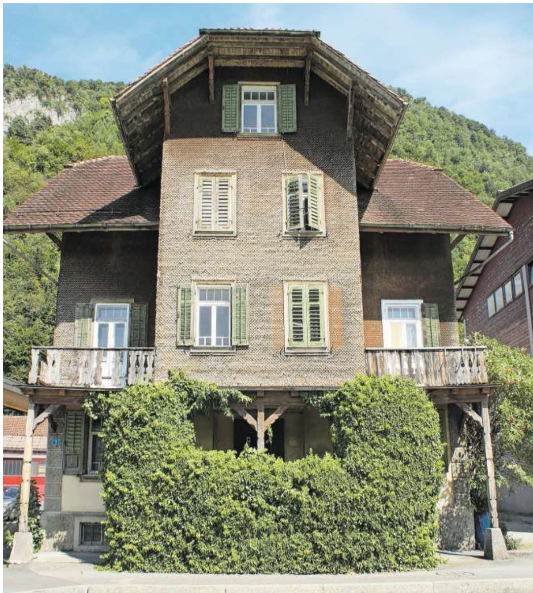
Das baufällige Büro- und Wohngebäude der Ober Sagi in Stansstad ist Ort der Ausstellung.
